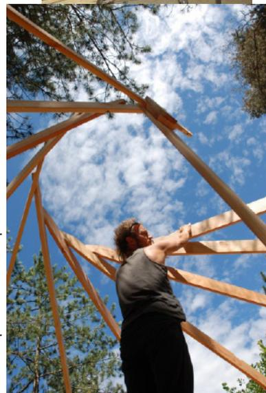
l'oeil" : on vise le bord de la coupole, à gauche, puis on se déplace sur la transverse pour trouver l'alignement avec tous les croisements de porteuses en essayant d'être en contact. Si besoin on se place 5cm plus haut que la transverse, car les perches sont flexibles.
